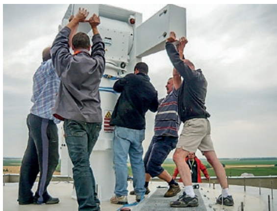
A radar-antenna összeszerelése
