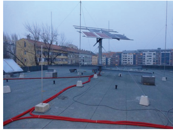
10. ábra: Villámvédelmi megoldás (foto Fejes Imre)
