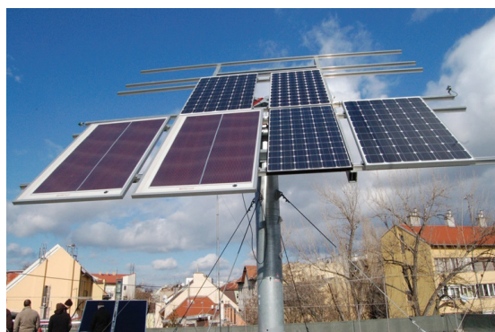
9. ábra: Napelem forgató berendezés és 3,5 kW p -os napelemes erőmű
