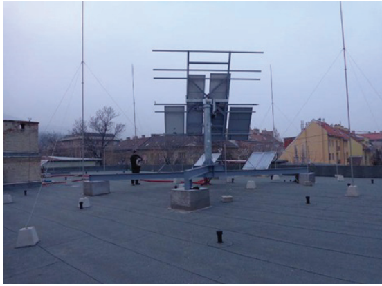
10. ábra: Villámvédelmi megoldás (foto Fejes Imre)
